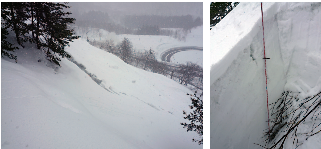
図 12 斜面頂部付近に観測されたクラック(左：地面まで達しているクラック，場所は図 10 中の A 地点，右：斜面途中に見られた新雪に隠された小クラック)
