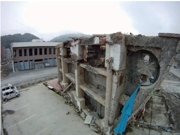
図 14 女川町の転倒した RC 建物 (7/7 竿カメラ 10 m)
