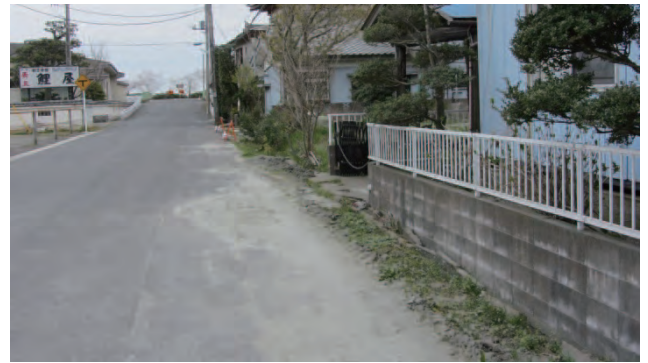
写真6 埋立地の噴砂(東庄町笹川) Photo 6 Sand boil in reclaimed land (Sasakawa, Tohnosho).
