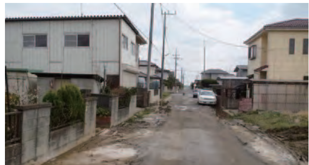
写真13 道路の噴砂(坂東市岩井グリーンランド) Photo 13 Sand boil spreading through a road (Iwai greenland, Bando).
