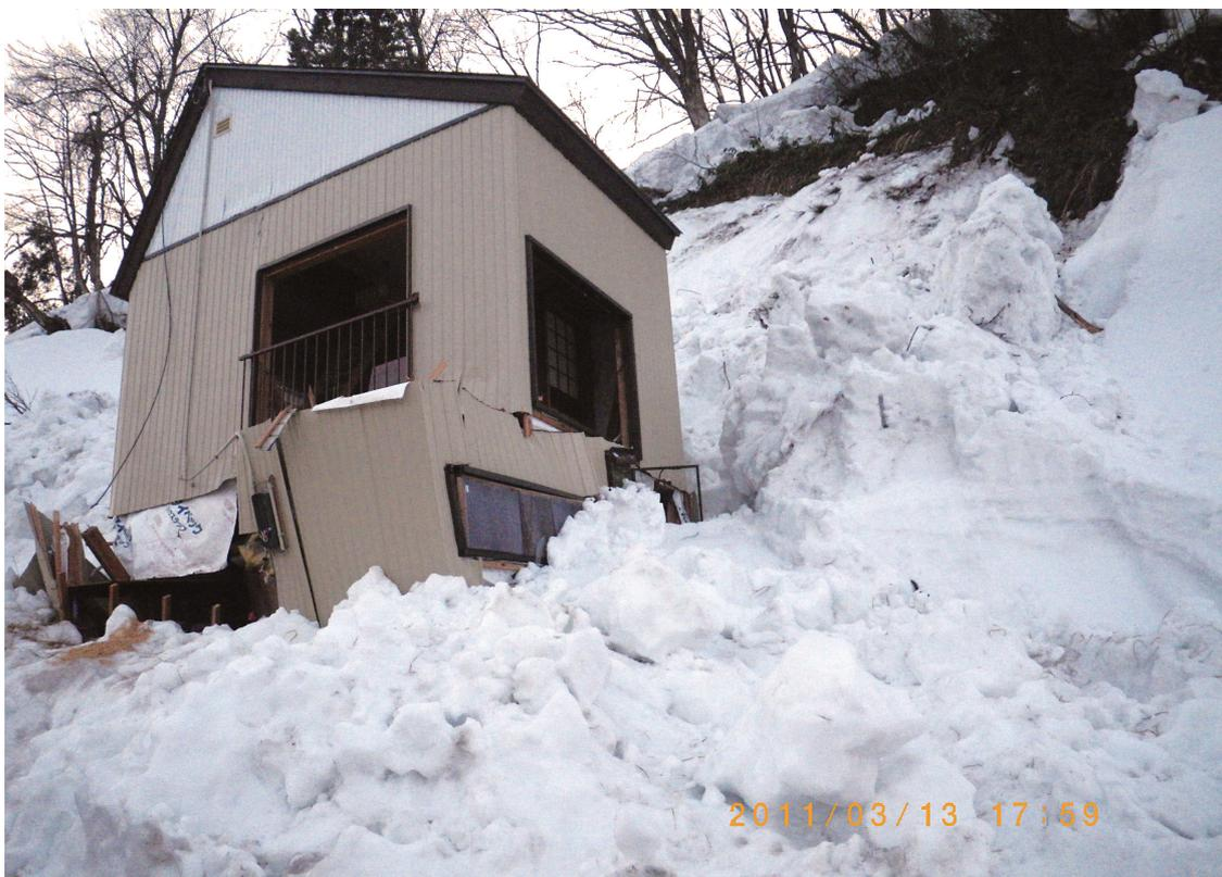
口絵 6 新潟県十日町市 2011年3月12日長野県北部地震による雪崩で被災した建物 [撮影：2011年3月13日]
