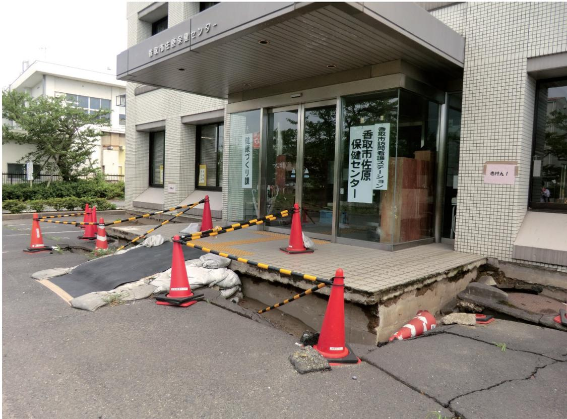
口絵 5 千葉県香取市佐原，香取市保健センター 地盤液状化による地盤沈下 [撮影：2011年7月21日]
