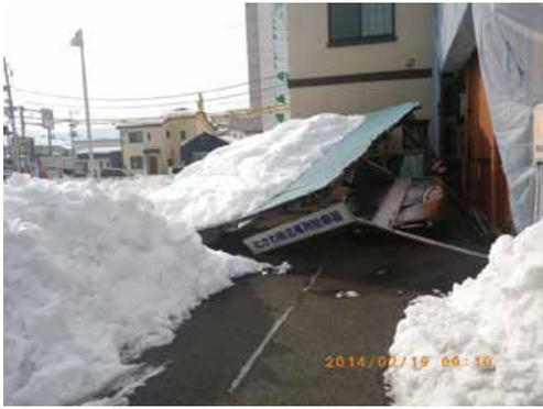
図 12 大雪によって倒壊した簡易駐車場と車の被害(甲府市 2/19)
