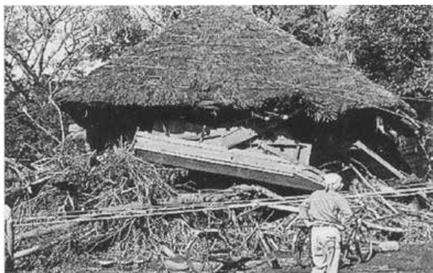
図 8 1958 年狩野川台風により発生した土石流が襲った 民家の被害 (場所：不明，出典：大島町町制施行 50 周年記念 事業実行委員会，2006)
