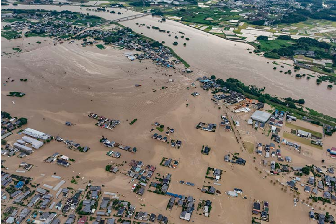
口絵 2 鬼怒川左岸 決壊地点 (撮影: 2015 年 9 月 10 日 16:48, 茨城県常総市三坂町, 上三坂地区)
