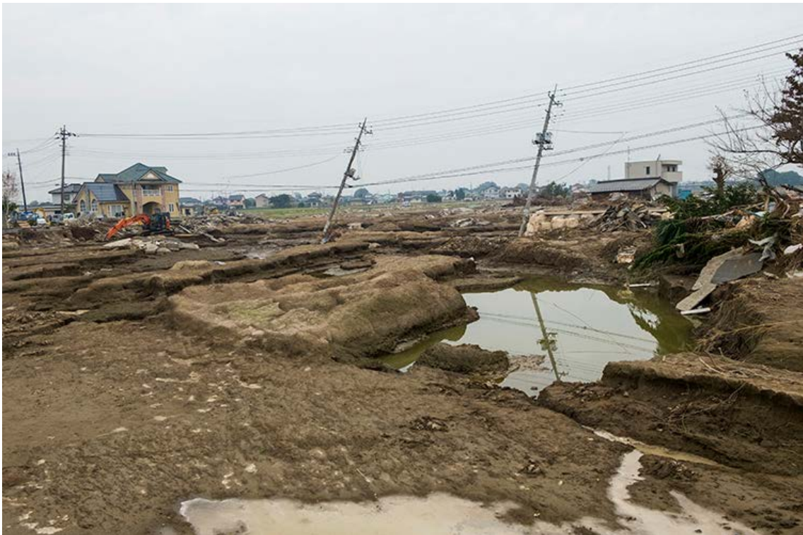
口絵 5 発災から 1 カ月後の鬼怒川堤防決壊箇所 (撮影：2015 年 10 月 10 日 12:28, 茨城県常総市三坂町, 上三坂地区)
