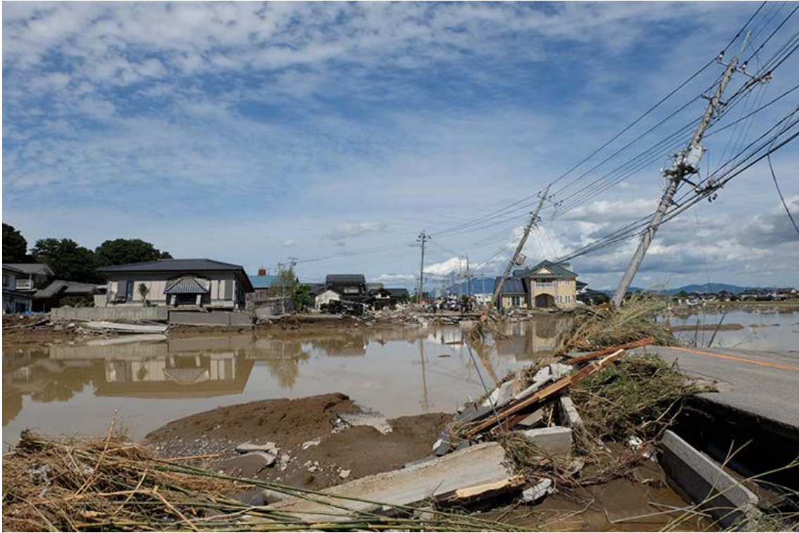
口絵 4 鬼怒川堤防決壊地点に形成された落堀 (撮影：2015 年 9 月 11 日 12:40, 茨城県常総市三坂町, 上三坂地区)
