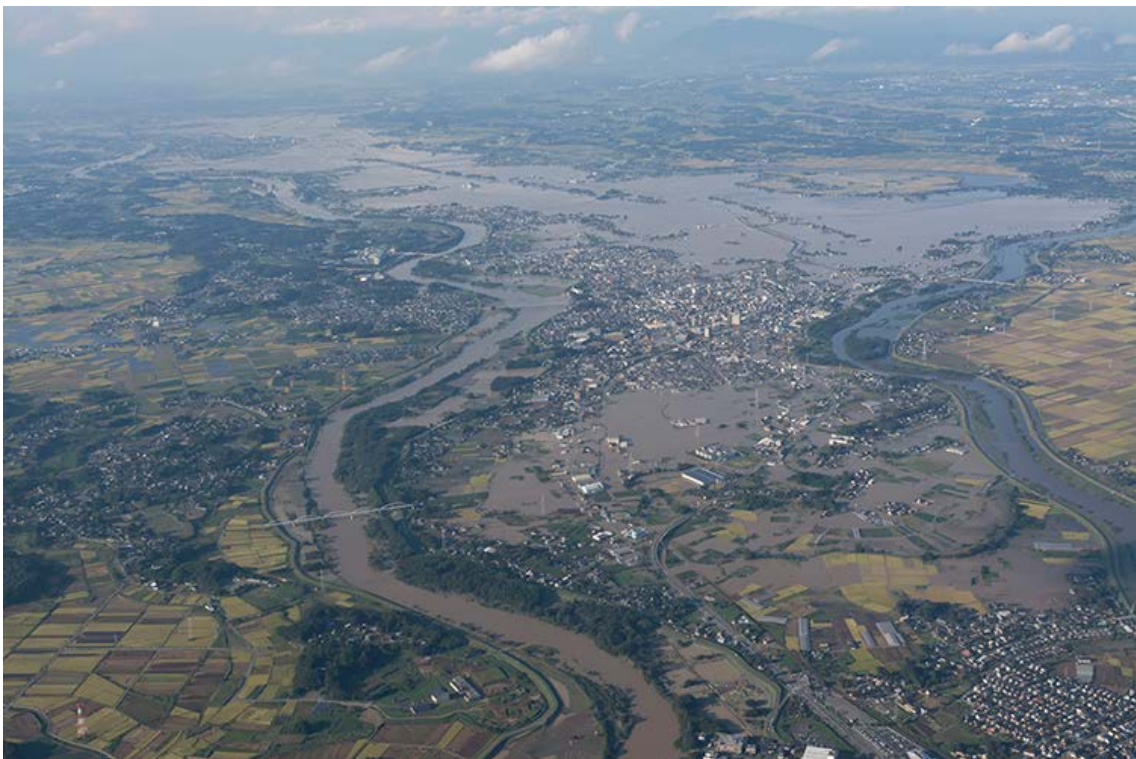
口絵 10 口絵 9 から約 24 時間後の鬼怒川の関東鉄道水海道車両基地周辺の洪水進行状況 (撮影：2015 年 9 月 11 日 16:18, 茨城県常総市水海道, つくばみらい市寺畑)
