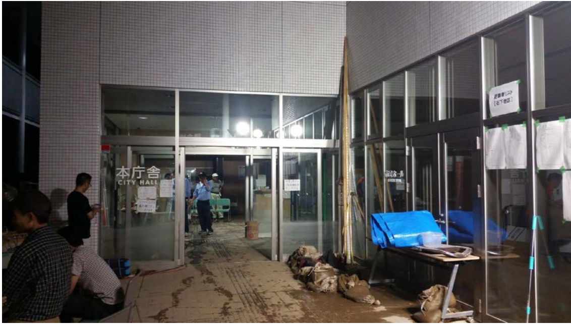
口絵 13 常総市役所本庁舎（撮影：2015 年 9 月 12 日，茨城県常総市水海道） Fig. 13 Joso city hall (September 12, 2015: Mitsukaido, Joso City, Ibaraki Prefecture).
