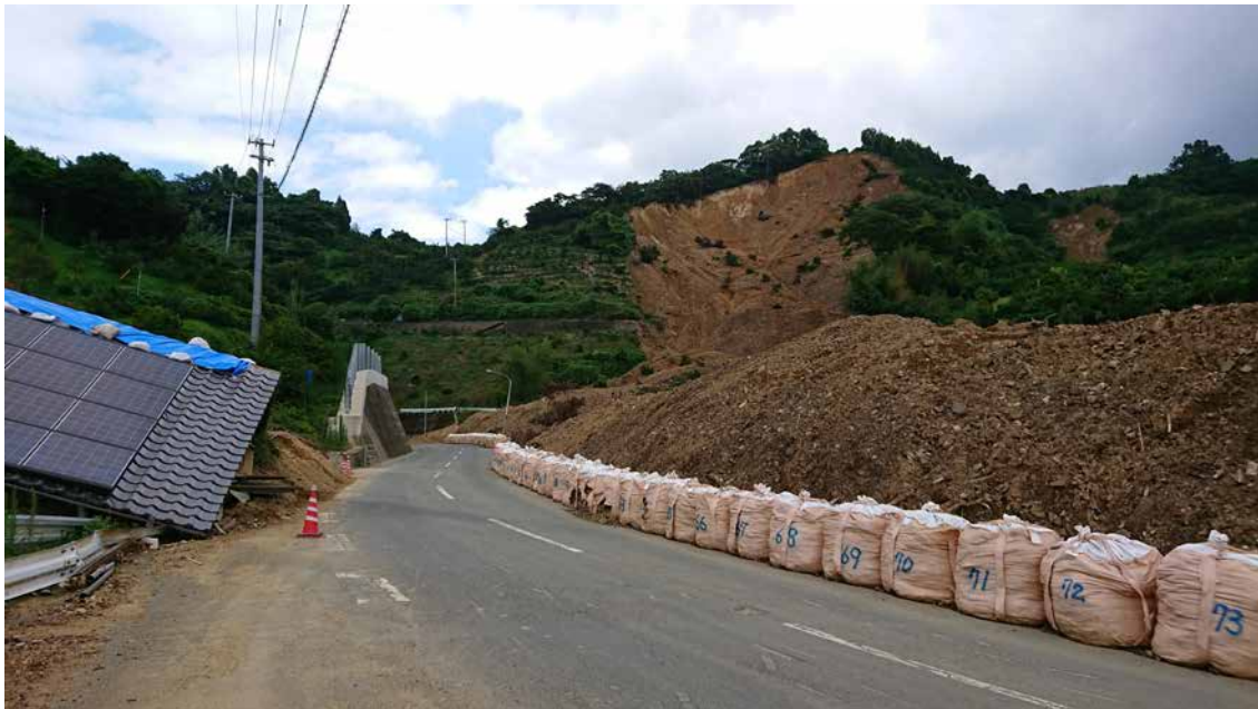
口絵 18 吉田町の斜面崩壊(撮影：2018年8月1日，愛媛県宇和島市吉田町) Fig. 18 Slope collapse at Yoshida-cho (August 1, 2018: Yoshida-cho, Uwajima City, Ehime Prefecture).
