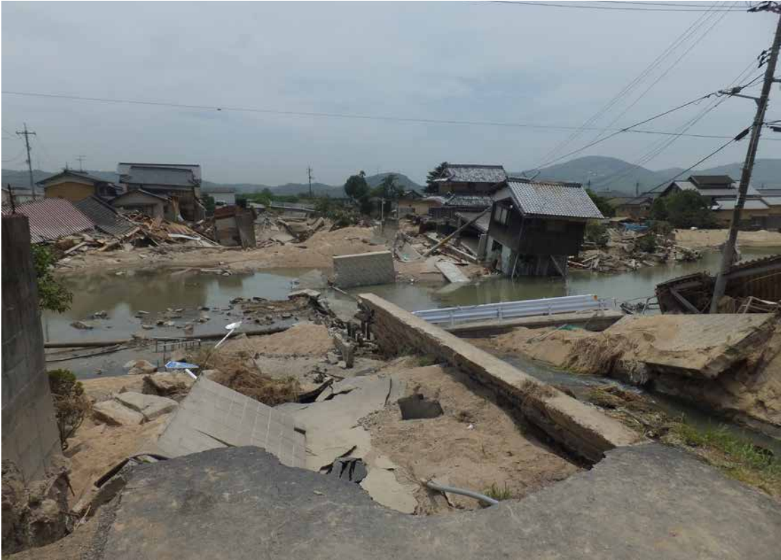
口絵 11 小田川支流末政川の決壊地点(撮影：2018年7月11日，岡山県倉敷市真備町有井) Fig. 11 Collapsed point of the Suemasa River, Oda River tributary (July 11, 2018: Arii, Mabi-cho, Kurashiki City, Okayama Prefecture).
