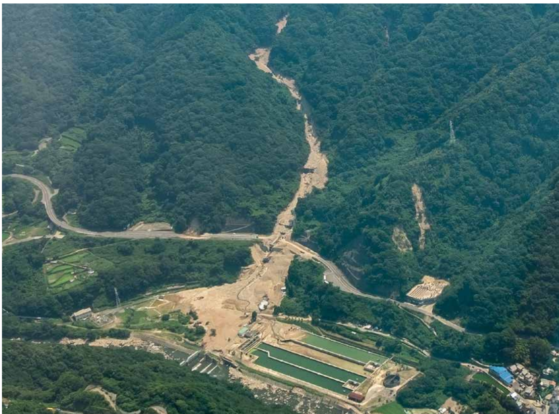
口絵 6 二級水源地の土石流被害(撮影:2018年7月25日,広島県呉市広町) Fig. 6 Debris flow to a second-grade water resource (July 25, 2018: Hiro-machi, Kure City, Hiroshima Prefecture).
