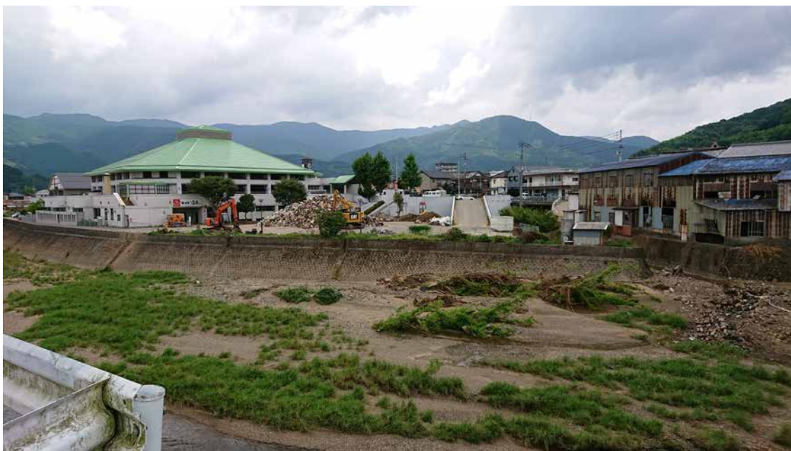
口絵 19 野村ダム下流に位置する肱川左岸の災害廃棄物仮置き場(撮影:2018年7月11日,愛媛県西予市野村町) Fig. 19 Temporary storage site for disaster waste on Hiji River's left bank, located downstream of Nomura Dam (July 11, 2018: Nomura-cho, Seiyō City, Ehime Prefecture).
