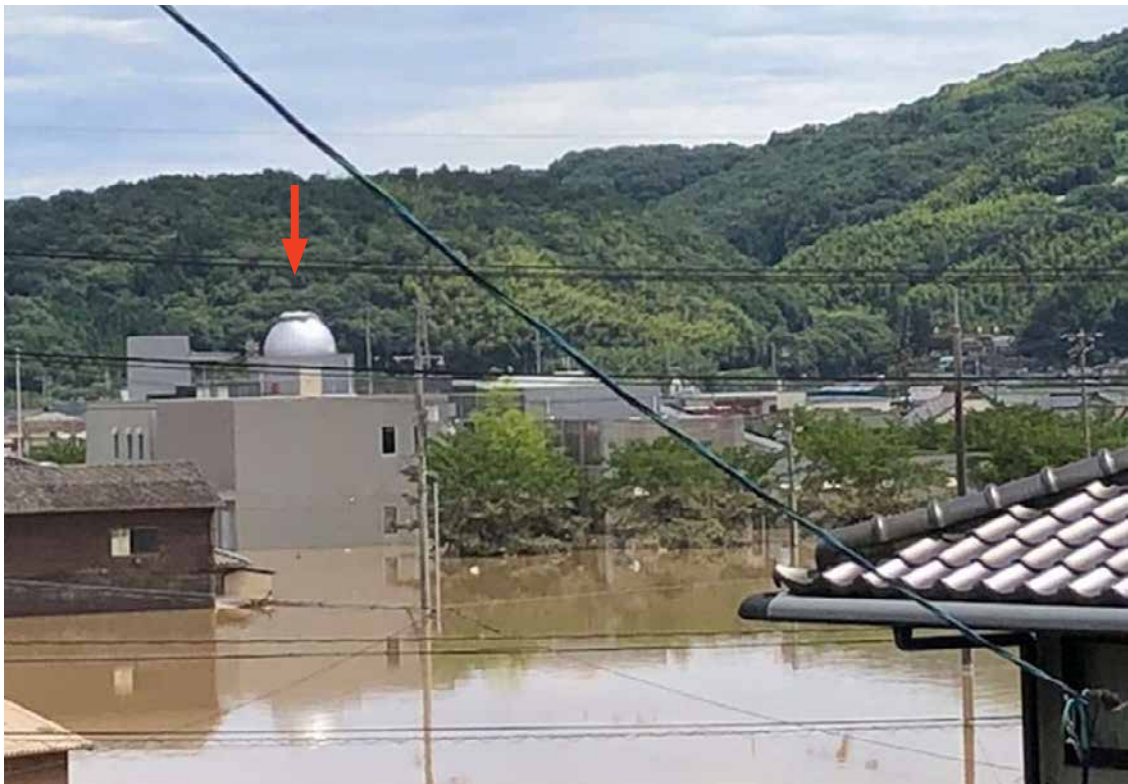
口絵 10 発災翌日の真備図書館(矢印)の浸水状況(撮影:2018年7月8日,岡山県倉敷市真備町箭田,提供:倉敷市立真備図書館) Fig. 10 Flood damage at the Mabi Library, indicated by the red arrow (July 8, 2018: Yata, Mabi-cho, Kurashiki City, Okayama Prefecture; Provided by the Mabi Library).
