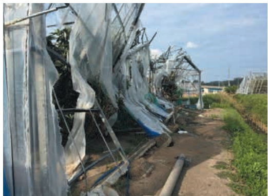
写真 15 南房総市 3 Photo 15 Minamiboso 3
