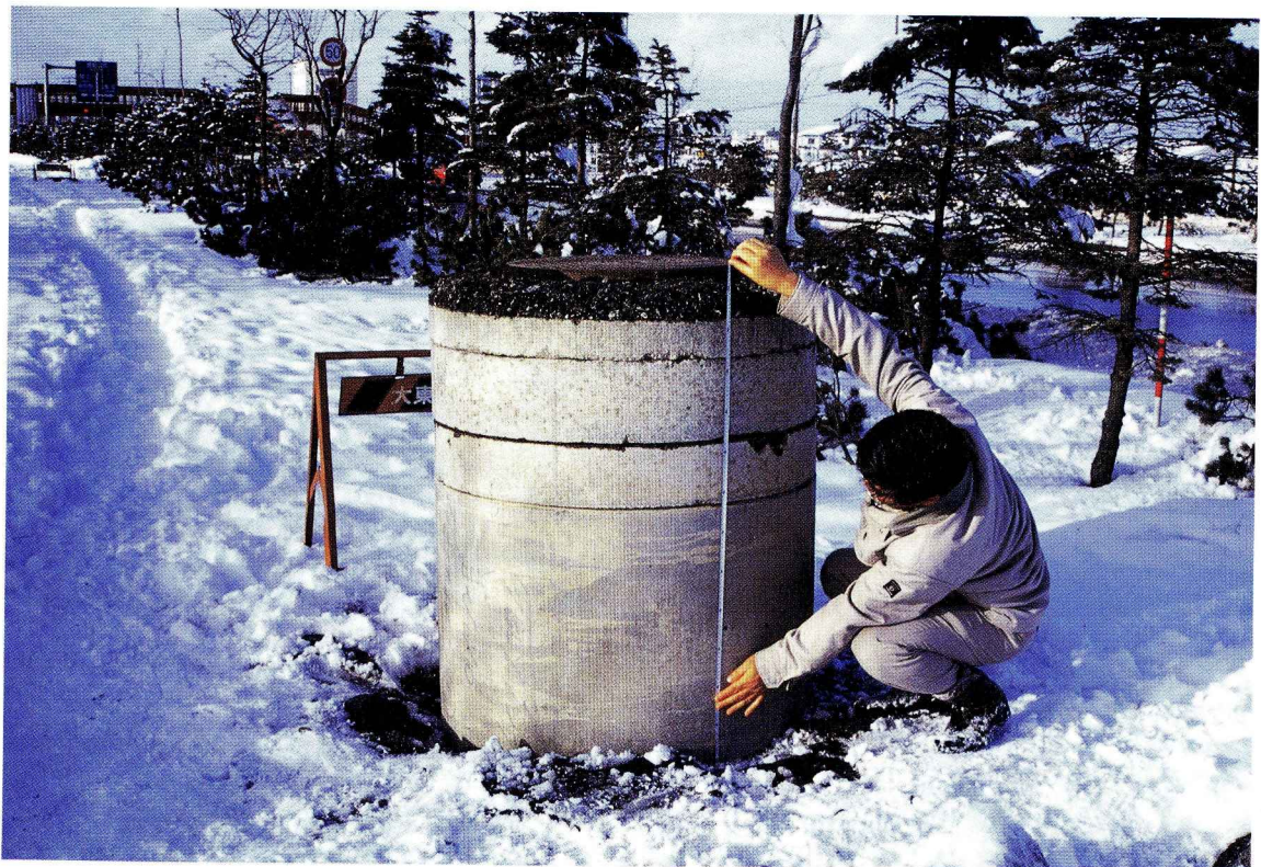
写真16 釧路町木場のバイパス脇歩道上に生じたマンホールの抜け上がり
