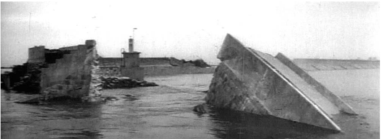
口絵2 高潮で破壊された海岸堤防（中日ニュース映画より）
