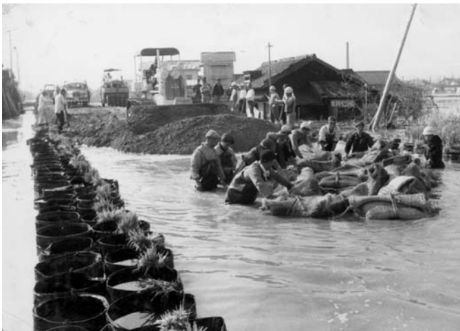
口絵19 ドラム缶工法による水没した国道一号線の復旧作業
