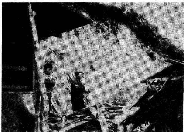
No. 11 後背のかけ地のくずれで建物 が破壊した例 函館市石崎町 (函館市 提供)
