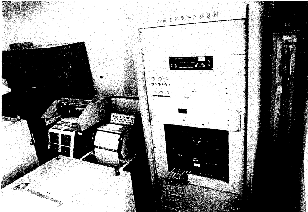
写真4 集中記録装置。送信されてきた各データを目視記録，磁気記録している。記録されたものは毎月1回，回収する。
