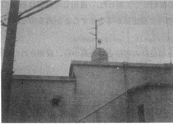
写真3. 受信アンテナ. それぞれ地震及び潮位観測点に向って設置されている.
