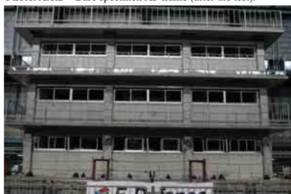
写真 A.2.2 旧基準試験体 X1 構面 (最終加振後)
