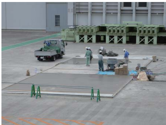
写真1 RC 橋脚製作ヤードの整備レベリングモルタルの打設
