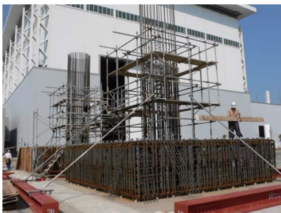
写真3 RC 橋脚フーチング鉄筋
