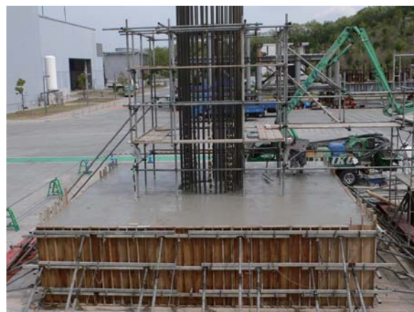
写真5 C1-5 試験橋脚 フーチングコンクリート打設後
