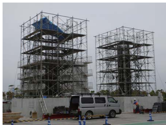
写真6 RC 橋脚試験体 フーチング脱型・帯鉄筋設置
