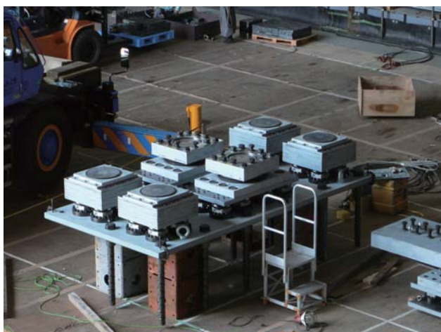
写真 20 試験体天端三分力計・支承 中央：固定支承 両サイド：滑り支承 Photo 20 Bearings and loadcells center: fixed bearings side: sliders.
