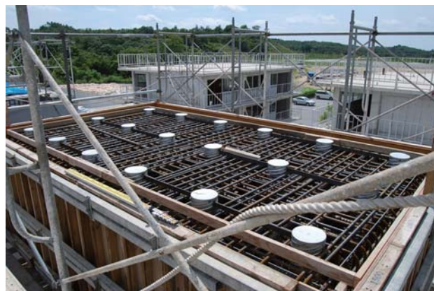
写真 11 梁部 鉄筋・型枠 アンカーバー箱抜き
