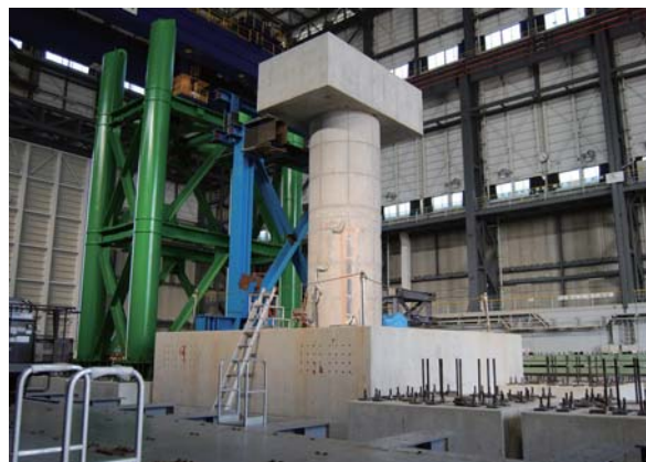
写真 16 端部・中央架台設置状況
