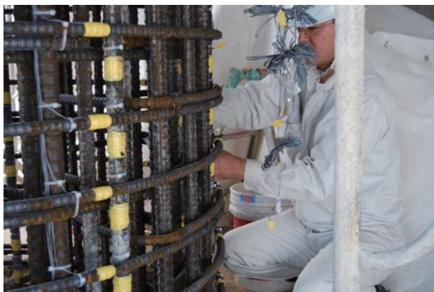
写真 7 C1-5 ひずみゲージ設置
