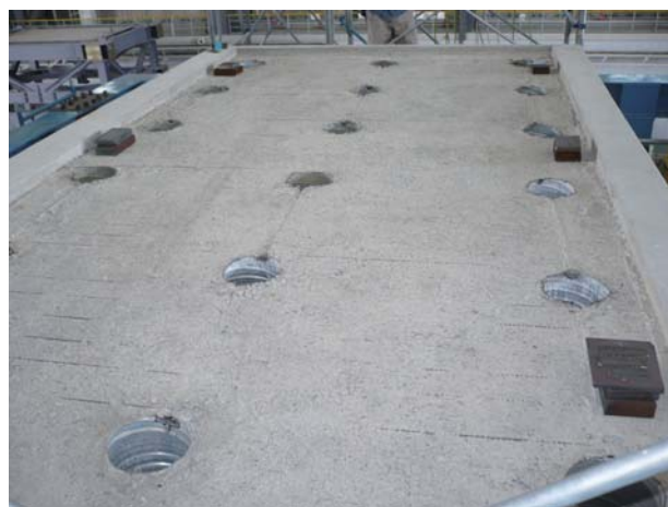
写真 18 試験体天端支承設置前
