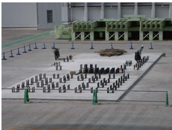
写真2 アンカーボルト用シース管固定治具設置
