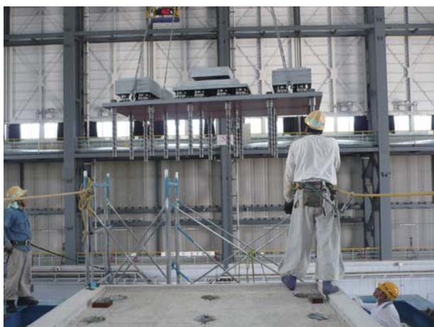
写真 21 試験体天端支承設置状況 Photo 21 Set bearings at the column top.
