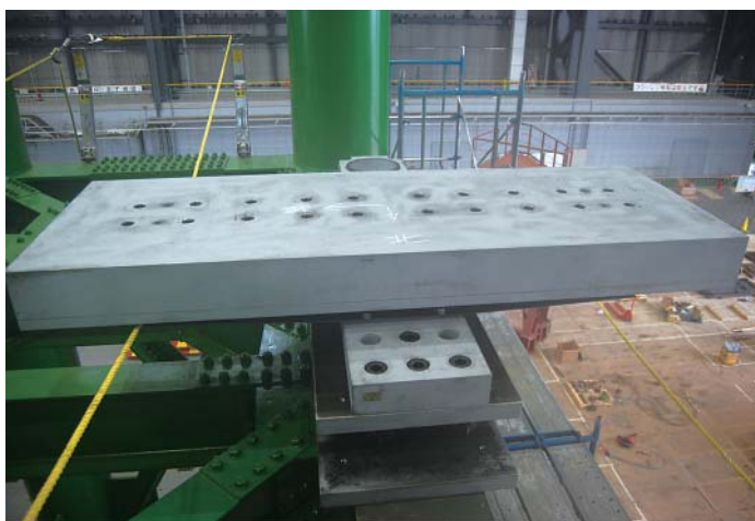
写真 26 端部架台上可動支承設置
