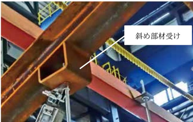
写真 2.5.3 吊り元および斜め部材受け
