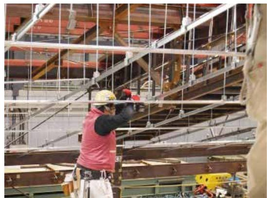
写真 7.3.2 野縁受けジョイント部ビス止め
