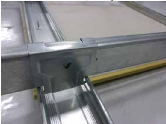
(b) ダブル野縁とダブルクリップ (JIS 規格品)
