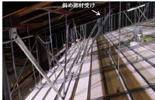
図 2.4.4 斜め部材上端部と斜め部材受け
