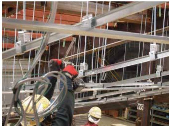
写真 7.3.1 ハンガーへのビス打ち状況
