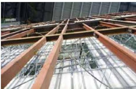
写真 3.2 全加振後の屋根ブレースの座屈変形
