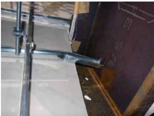
壁際野縁の端部が座屈している
