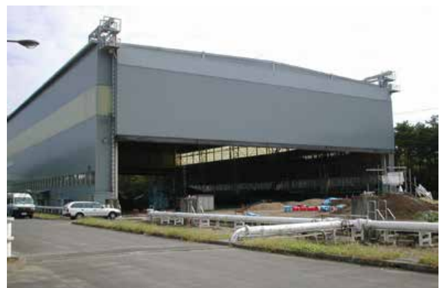
図1 大型降雨実験施設 Fig. 1 Large-scale rainfall simulator.
