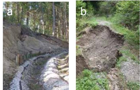
図3 林業作業道に見られる法面崩壊(a)および盛土の崩壊の例
