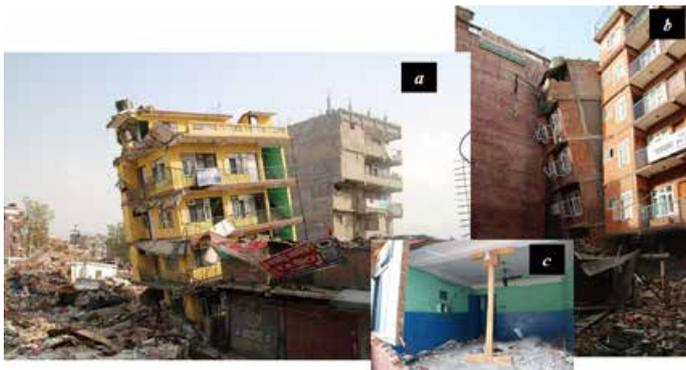
図 5.1 Gongabu の傾いた建物 (a,b). 1 階部分仮支え状況 (c)
