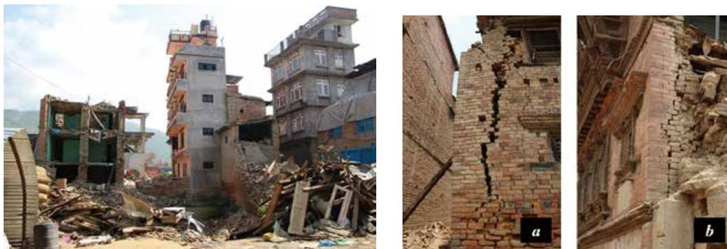
図 5.4 RC の建物は健全で構造形態の違い(左図). RC の建物は健全で構造形態の違い RC 枠組の存在しない組積造(レンガ)+セメント/マッド・モルタルの住宅 : (a), 隅角部からクラックが生じ, 外側の焼いたレンガのセメント・モルタル目地 BC とその内側は日干しレンガのマッド・モルタル構造 BM : (b)
