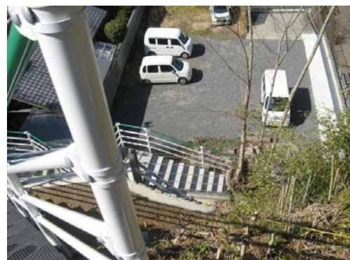
図 4.8 四国・高知県四万十市下田の高さ 20 m の階段式避難施設
