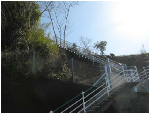
図 4.8 四国・高知県四万十市下田の高さ 20 m の階段式避難施設
