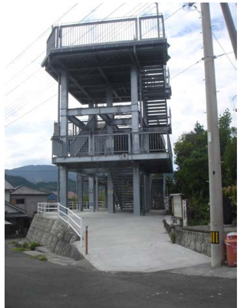
図 4.7 四万十市下田の津波避難タワー
