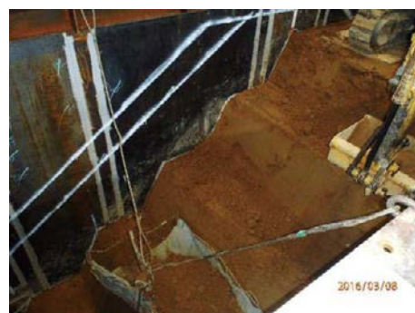
写真 15 シート敷設部の段切り状況 Photo 15 Bench-cut construction.
