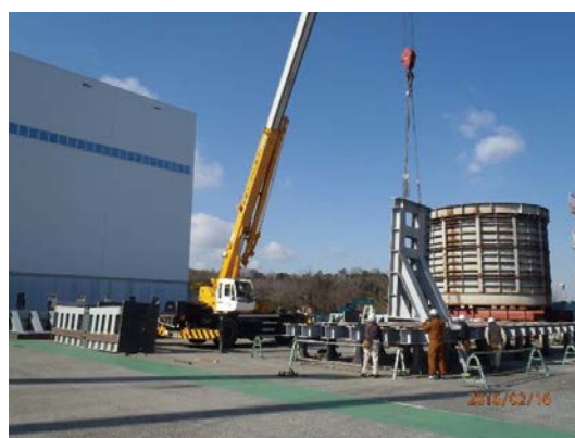
写真 6 土槽組立状況
