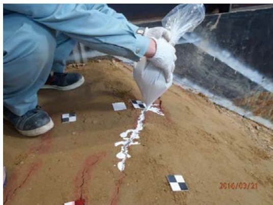
写真 20 石灰の流し込み状況 Photo 20 Pouring lime into the cracks.
