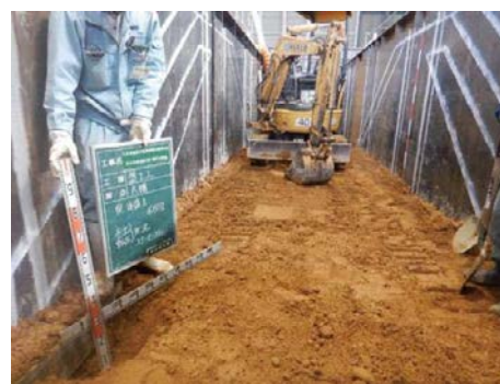
写真 12 敷均し状況 Photo 12 Spreading embankment materials.
