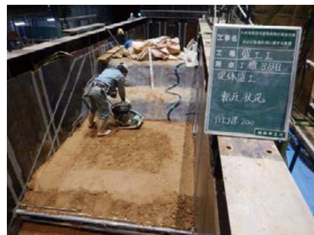
写真 17 プレートによる転圧状況 Photo 17 Compaction using a plate compactor.
