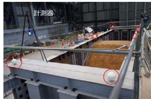
(a) ターゲット配置状況(土槽上)
