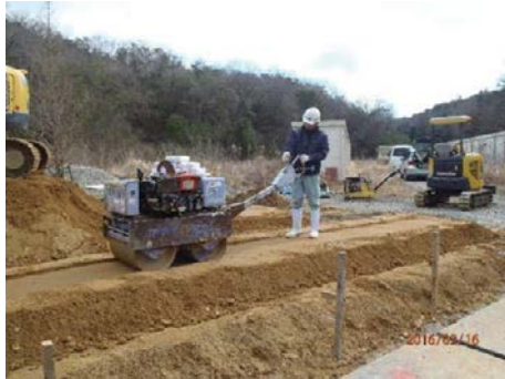
写真9 ハンドローラーによる締固め状況 Photo 9 Compaction using a vibrating roller.
