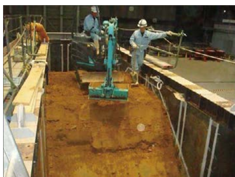
写真 14 法面整形状況 Photo 14 Slope face shaping work.
