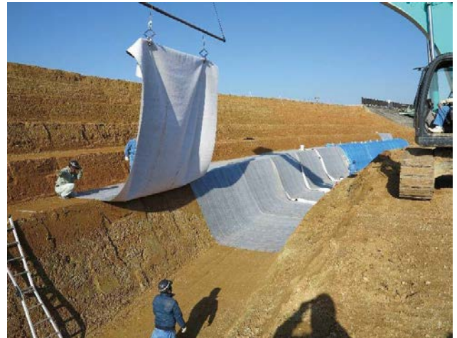
写真 4 ベントナイト系遮水シートの現場施工状況 Photo 4 Repair construction of small earth dam using GCLs.
