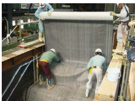
写真 16 シート敷設状況 Photo 16 Installation of GCL.
