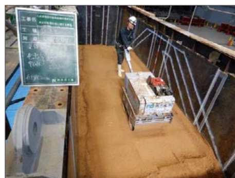
写真 13 ローラーによる転圧状況 Photo 13 Compaction using a vibrating roller.
