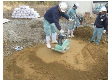
写真10 プレートを用いた締固め状況 Photo 10 Compaction using a plate compactor.
