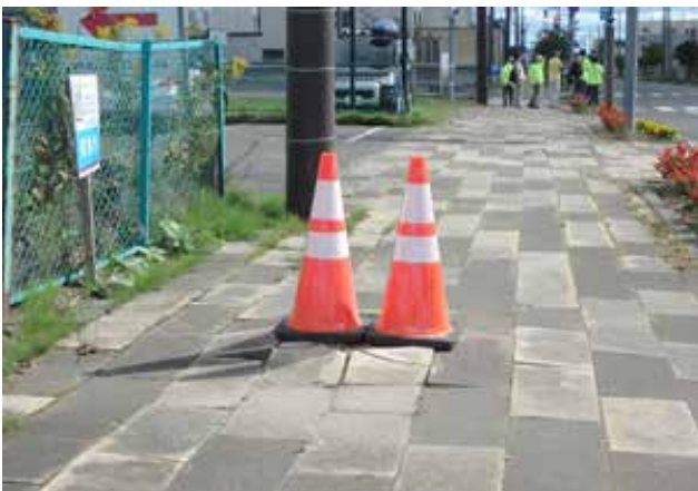
写真5 安平町内のマンホールの浮き上がり(2018年北海道胆振東部地震)
