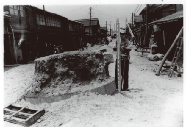
写真2 新潟市内のマンホールの浮き上がり(1964年新潟地震)
