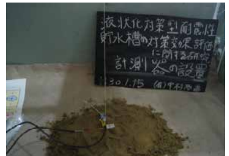
(i) 間隙水圧計の設置
