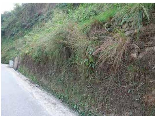
写真8 裏込土の流入と植生の繁茂による透水性の低下
