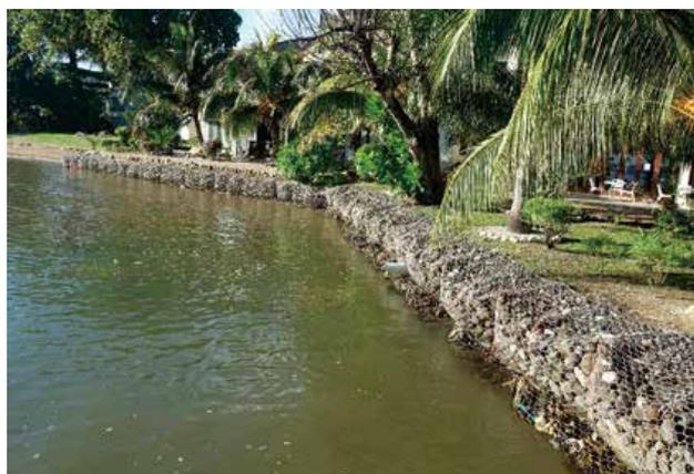
写真 2 ソロモンで港湾施設に使用されている蛇籠の例
