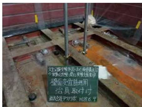
(i) センサ取付け治具の設置
