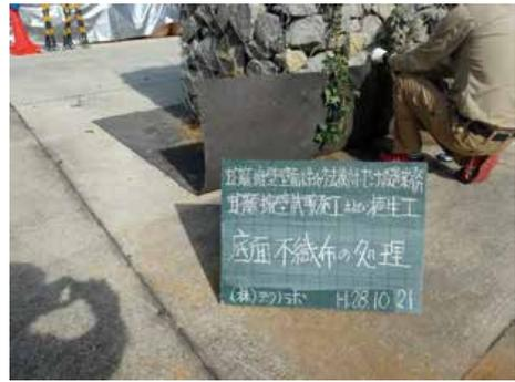
(t) 蛇籠擁壁試験施工および植生工完了
