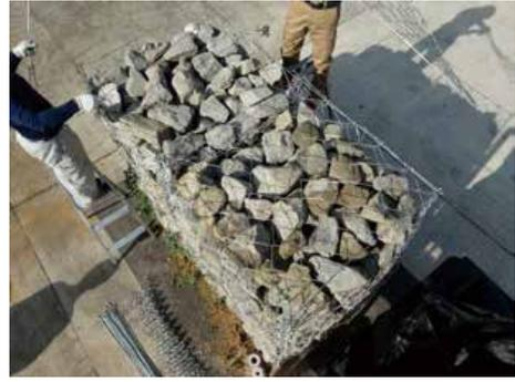
(s) 蛇籠2段目中詰め工および底面不織布の巻上げ
