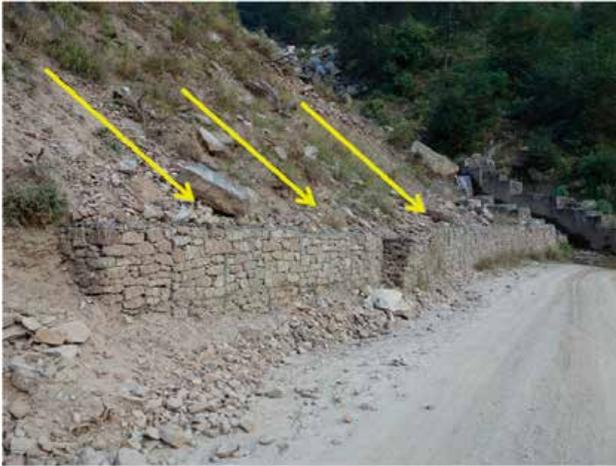
図1 背面からの土砂崩れに耐えた蛇籠道路擁壁の例 (地点 99)
