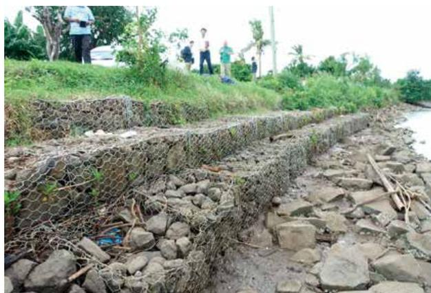
写真 3 フィジーで河川護岸に使用されている蛇籠の例
