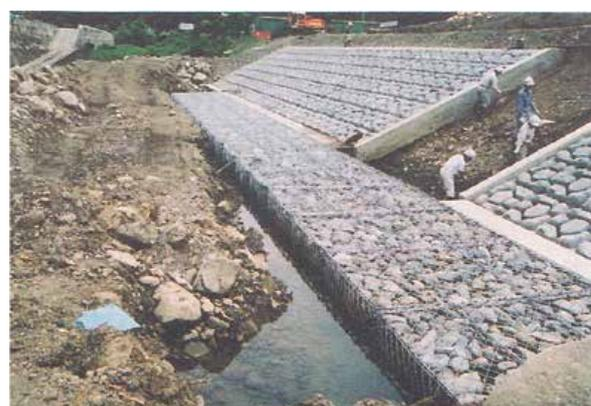
写真5 角形蛇籠の根固め工への使用例（じゃかご工法の手引きと解説より抜粋）
