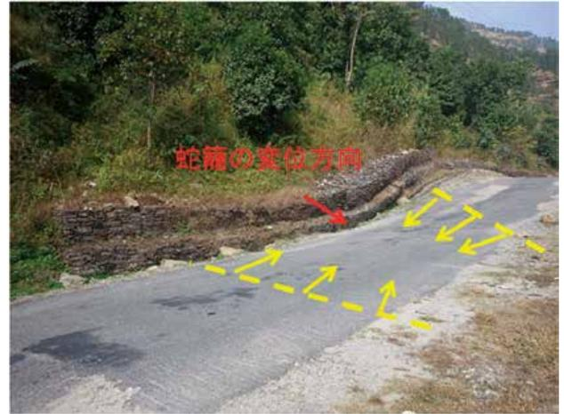
図2 基礎地盤の変形に追従した蛇籠道路擁壁の例 (地点 81)
