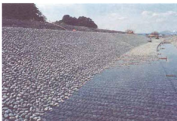
写真4 円筒型蛇籠の法覆工への使用例（じゃかご工法の手引きと解説より抜粋）
