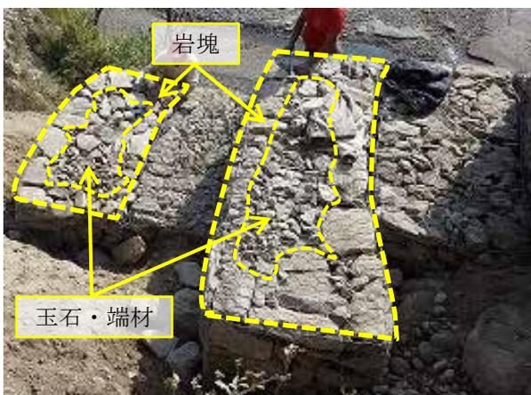
図6 粒径の異なる中詰材の投入状況
