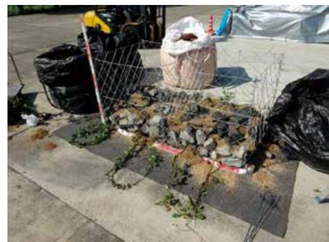
(i) 植栽完了(植栽上に割ぐり投入・敷き並べ(1層150mm程度)および植生土(まさ土)充填)
