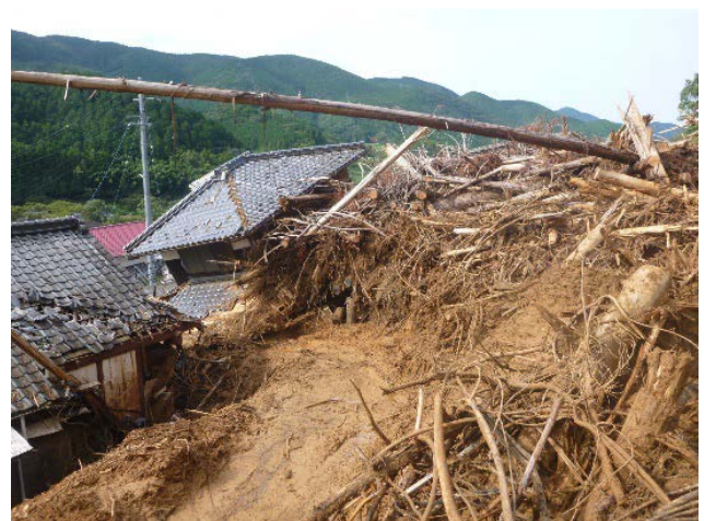
写真3 人家被災状況
