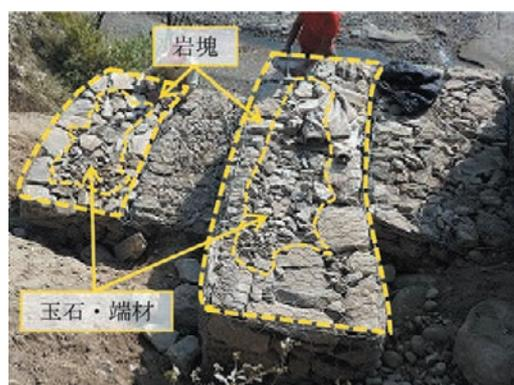
写真 7 粒径の異なる中詰材の投入状況<sup>3)</sup>
