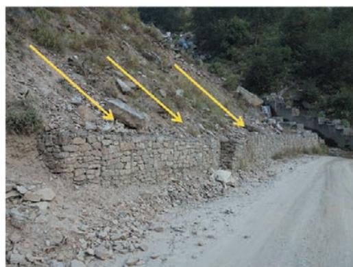
写真4 背面からの土砂崩れに耐えた蛇籠道路擁壁の例<sup>3)</sup>
