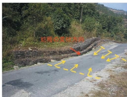
写真5 基礎地盤の変形に追従した蛇籠道路擁壁の例<sup>3)</sup>
