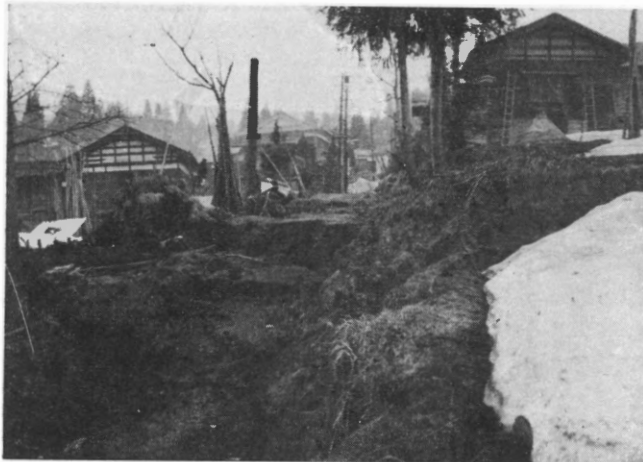
新潟県松之山町地すべり災害（昭和38年4月）
