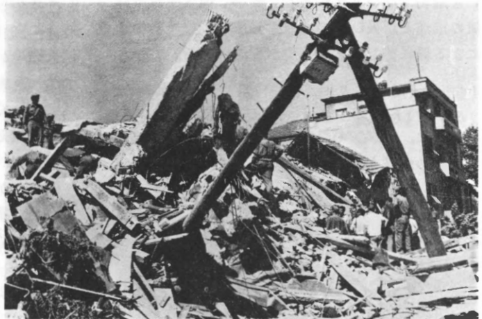
ユーゴ スコブリエの地震（昭和38年7月29日）
