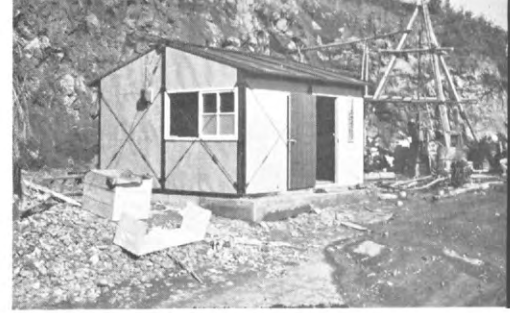
写真—II えびの吉松地区地震観測井の設置工事と測定室
