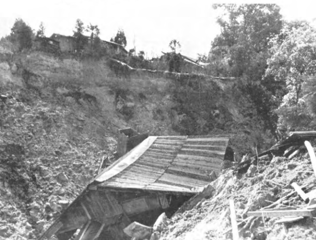
写真—1 えびの地震で起きたがけくずれで 落ちた民家（宮崎県えびの町，幣田）
