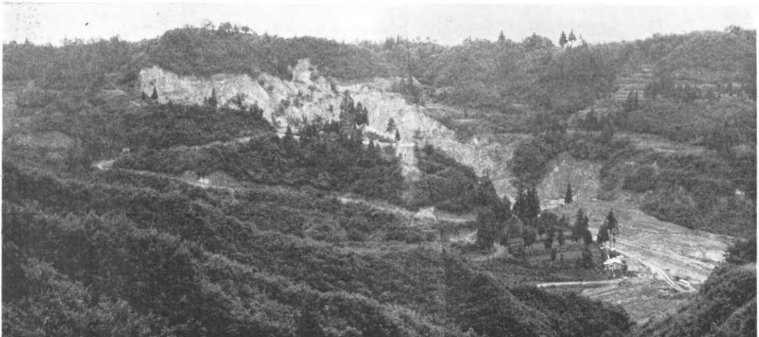
写真-1 水沢新田の地すべり性崩壊
