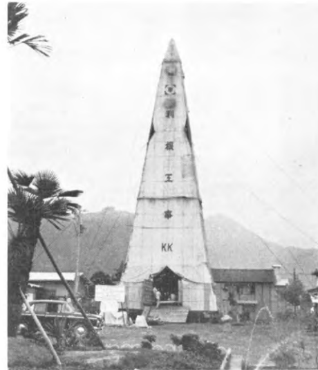
写真-1 ボーリングの全景
