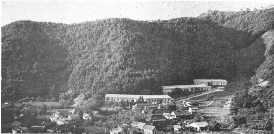
写真-1 地震観測所全景 庁舎裏山に小坑道、左端山中に大坑道がある
