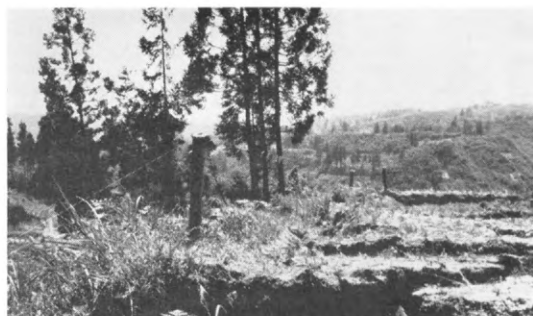
写真一四 上部のクラックをはさみ設置した本器
