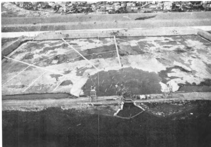
写真—4 荒川における破堤氾濫実験
