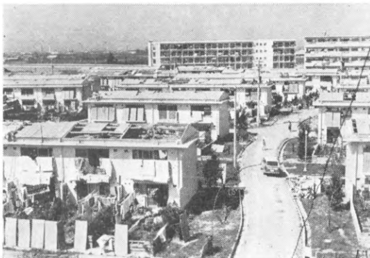
写真-1 第2室戸台風の被害（公団中百舌鳥団地）
