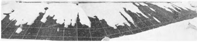
写真-3 道路消雪実験
