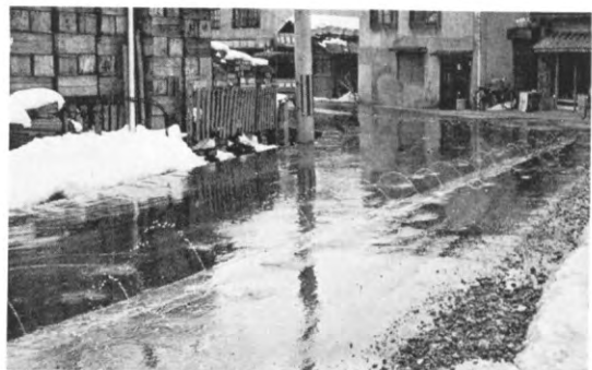
写真—2 消雪道路
