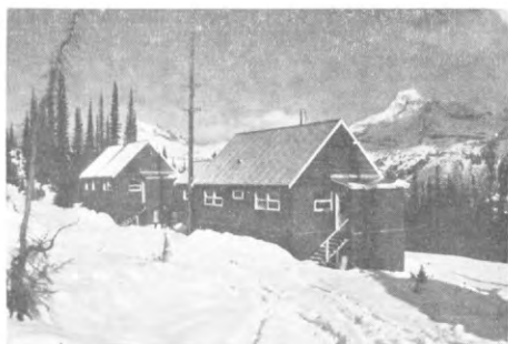
写真-9 カナダ北部開発省付属の雪崩発生予防のための雪観測所、ロッキー山脈内のフィデリティ山の高度1,900mの所にある
