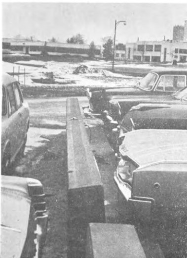
←写真-6 国立科学研究所構内での駐車場 仕切り帯の凍上による傾き
