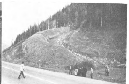
↑写真-8 ロッキー山脈中にある雪崩防止堤 の一つ、透導型土堤
