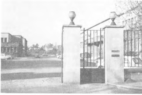
写真-1 フランス電力水理研究所正門
