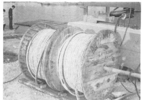
写真-2 水中用の鎧装ケーブル
