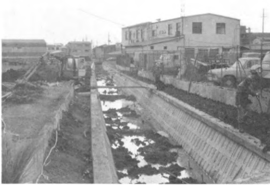
写真-5 内水排除のための排水路の改修状況
