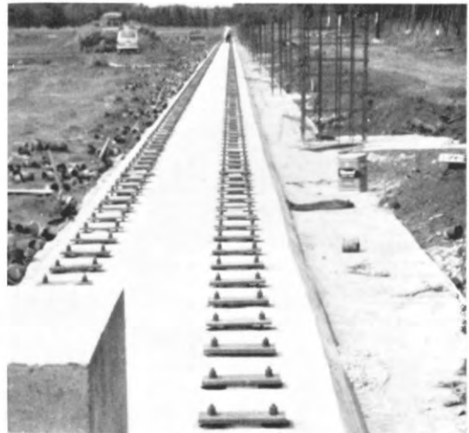
昭和45年度完成した大型移動降雨装置基礎の一部で、移動用軌条床が延々と連なる基礎構造下部は、堅固な砂層地盤に達する450mm 30度斜杭、400mm 直杭が約5m 間隔で2列に設けられている。
