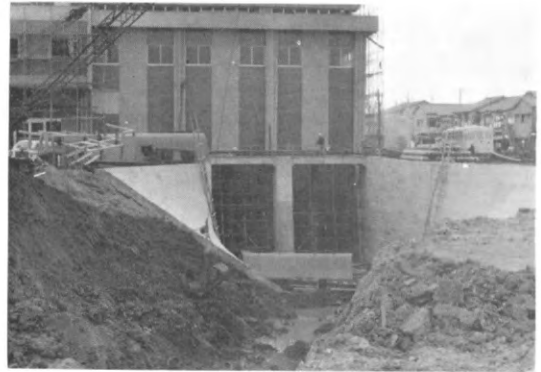
写真-6 内水排除のためのポンプ場設置状況
