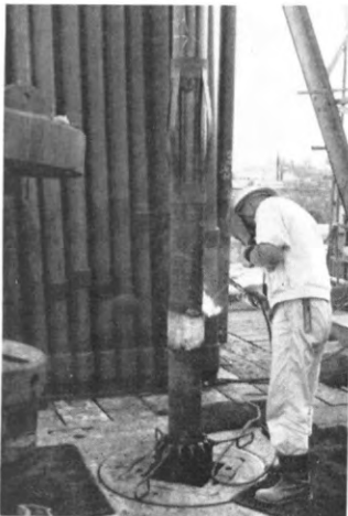
非磁性ケーシング孔内に挿入, 7" ケーシングにセントライザー固定降下
