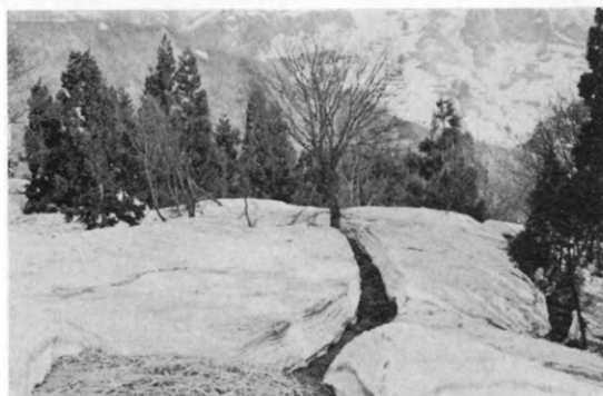
写真-1 地すべり発生前にみられた亀裂
