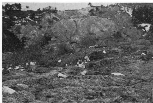
写真-2 地すべり地前面, 手前は押し出した土砂
