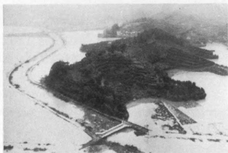
土佐市郊外の湛水状況 (高知県提供)
