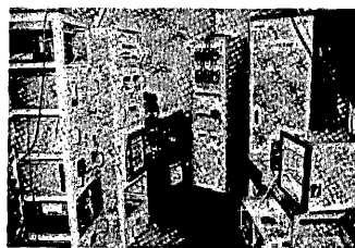
観測塔の内部
