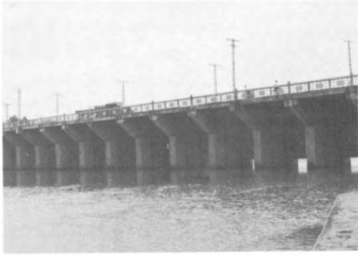
写真2 東平湖滞洪区より出口の水門：40億 m^3 の総貯水量のうち20億 m^3 が洪水調節に用いられる。東平湖には26万人が住んでいる。
