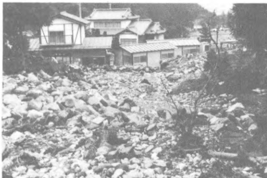
土石流に襲われ巨礫に埋った 須坂市仁礼地区 (9月11日撮影)
