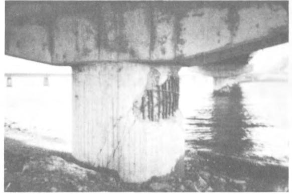
4. 静内橋の橋脚被害
