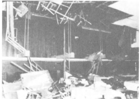
7. 浦河町福祉センター集合場天井の落下被害 (浦河町対策本部撮影)
