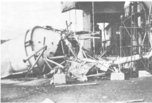
6. 三石町曳舞(けりまい)での生コン工場 コンクリートホッパーの転倒被害
