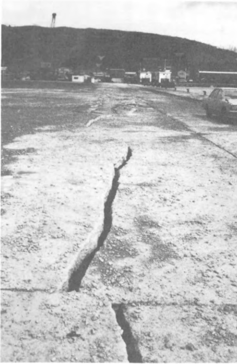
3. 浦河漁港の堤防沿いに発生した地割れ
