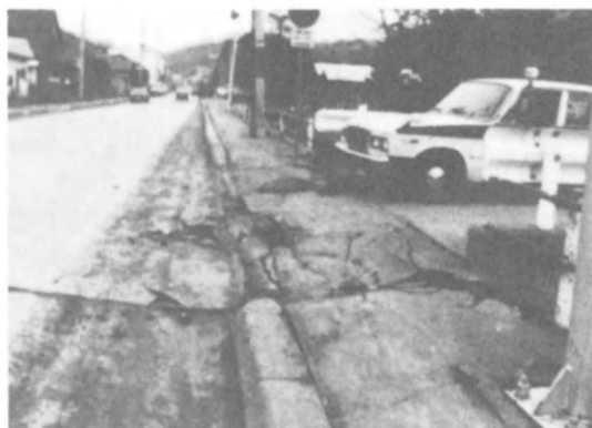
1. 浦河町常盤通り沿いの道路被害
