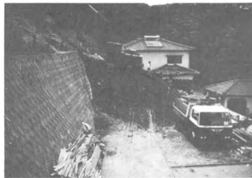
写真1 西高田地区、ミニ造成地崩壊による災害
