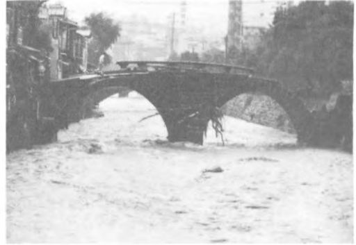
写真7 上部は流失したがアーチ部は残った眼鏡橋（石橋は長崎市内に19橋あり、内10橋が流失した。）
