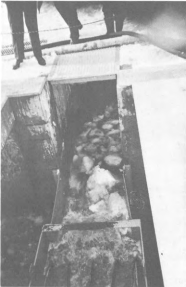
写真2 流雪溝から攪拌槽に入る状況
