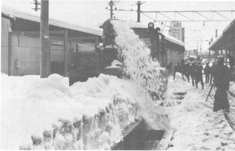
写真1 モーターカー除雪車での雪の投入
