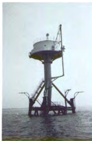
波浪等観測塔の全景写真
