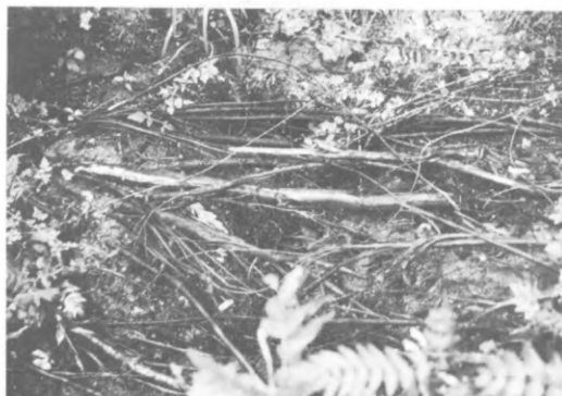
写真9 クラックにそいつ張り力をうけた木の根
