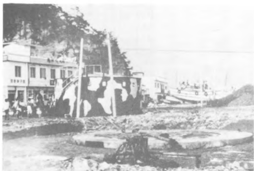
写真2 臨院では津波のために13万リットル入りの燃料タンクが移動した。タンクは津波が来る前には写真手前の円形コンクリート基礎のところにあった。この町で船員2名が行方不明になった。水路局秋教昇氏提供。以下の写真も同じ。
