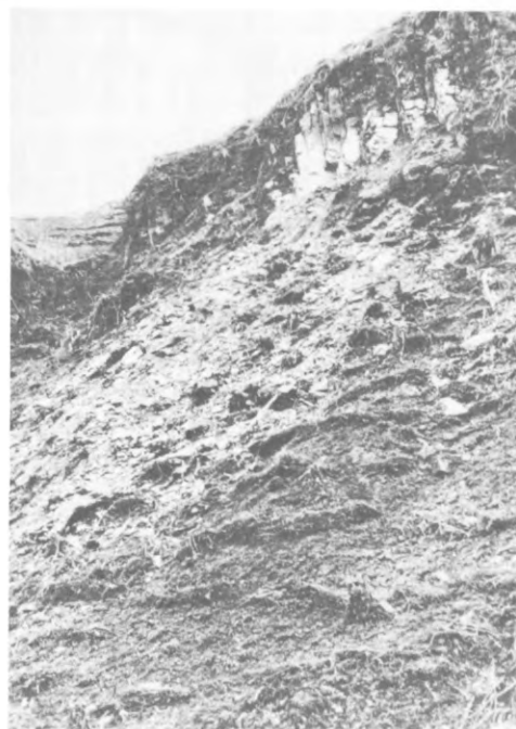
写真16 倉越原溶岩層の崩壊、柱状の節理が明瞭（御岳高原有料道路入口付近）
