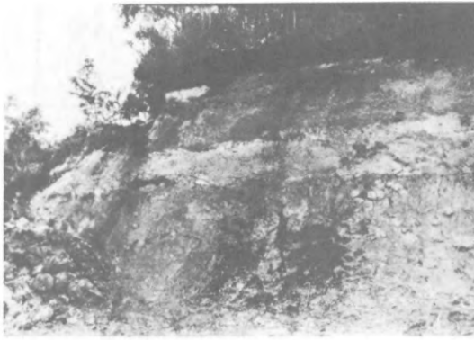
写真13 C崩壊に続く道路の切り取り斜面（左端はC崩壊）。白色軽石（Pm-I層）で崩壊していることが解かる。
