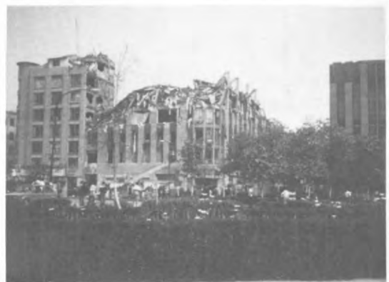
メキシコ市内のビルの倒壊(10月1日撮影)
