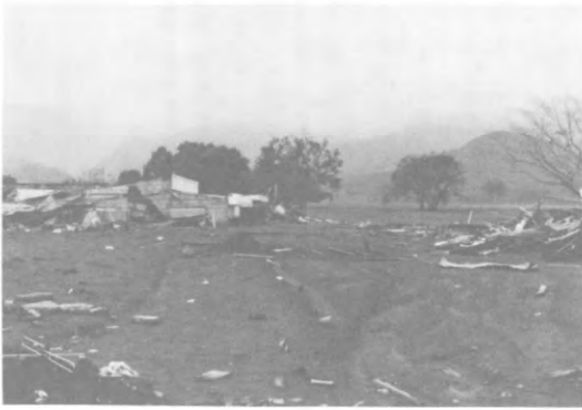
写真1 泥流の通過した後のアルメロ市街地の状況 (気象庁, 田中康裕火山室長提供)
