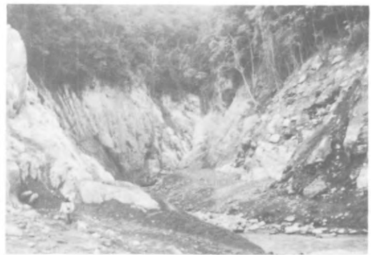
写真2 泥流によって大きくけずられた沢 (気象庁, 田中康裕火山室長提供)
