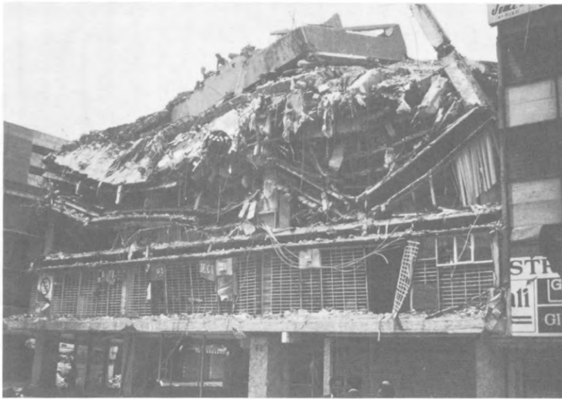
写真2 全体が崩壊した4階建校舎
