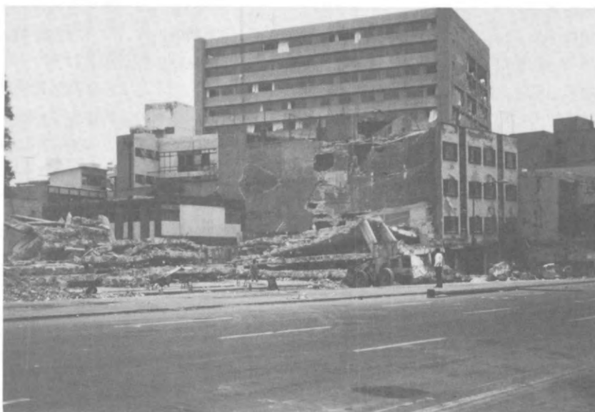
写真1 中層建物の上層部が崩壊した建物
