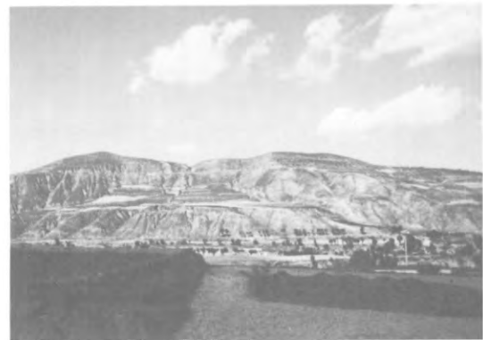
写真2 通渭地すべり全景
