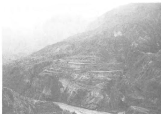
写真4 紅土坡地すべり
