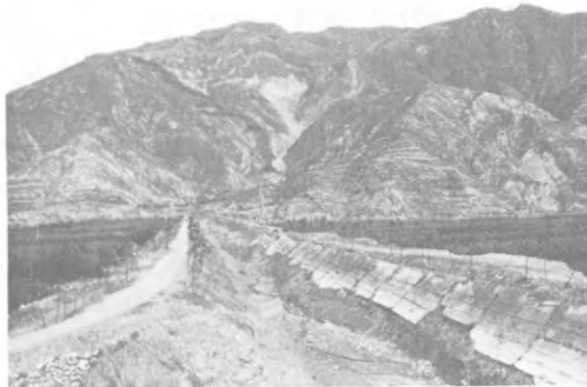
写真6 白竜江沿いの土石流溪流
