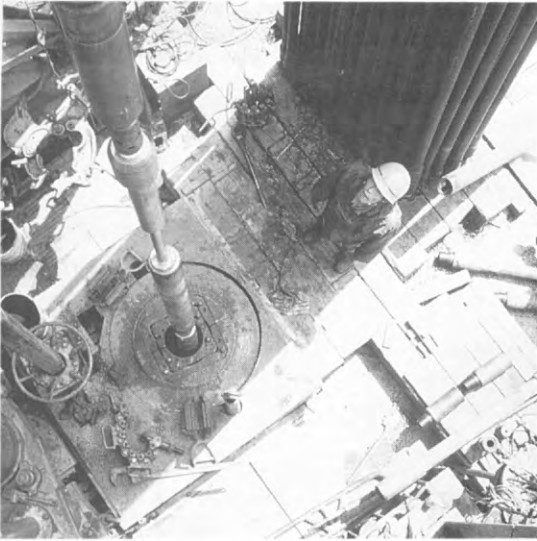
写真3 バッカー（栓）を孔内に降ろそうとしているところ。孔口（写真中央）にバッカーの一部がすでに入っている。右上に多数のドリルパイプが立て掛けてあるのが見える。
